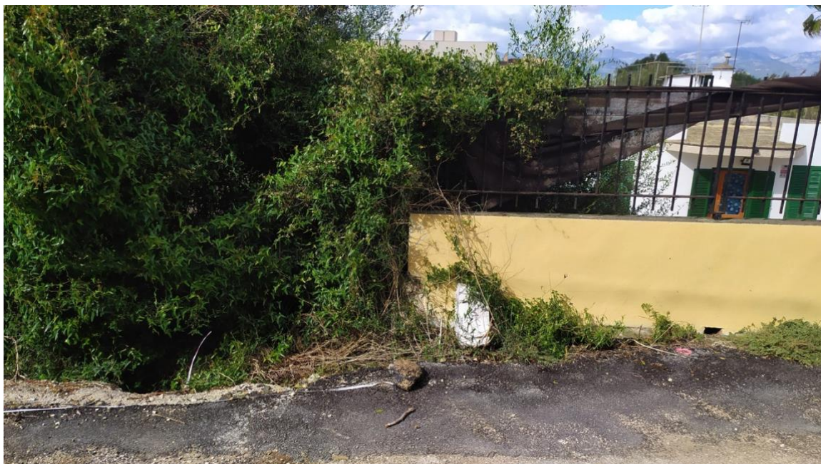
Foto 5. Límite de la parcela con muro de fábrica.
