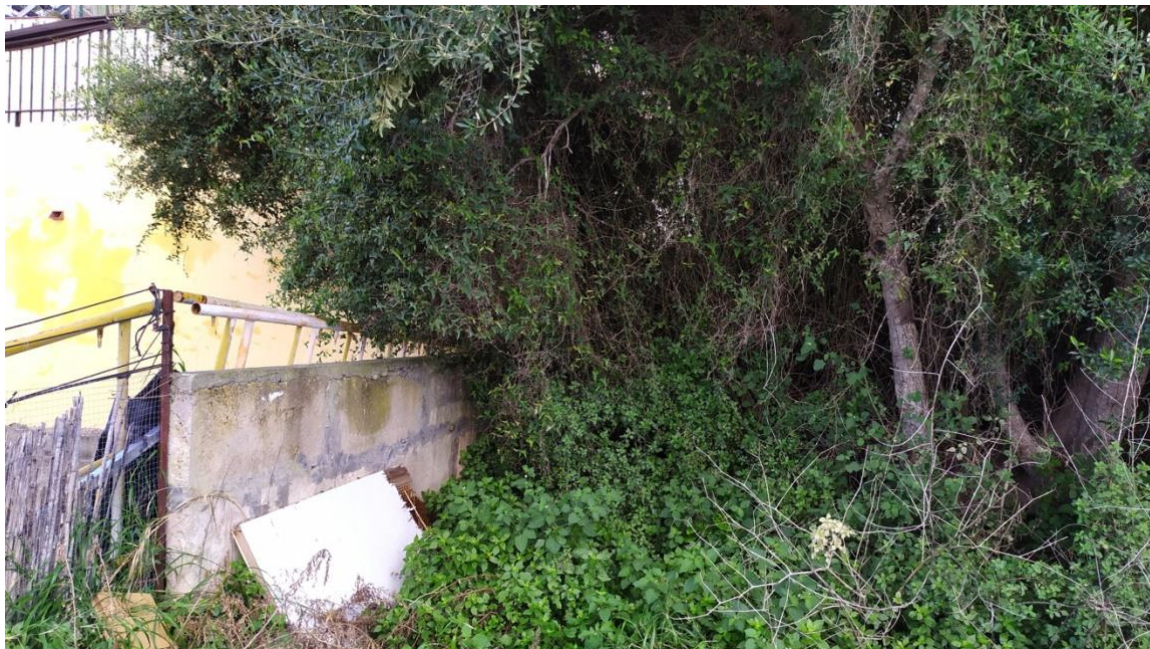
Foto 9. Límite de la parcela con muro de fábrica.
