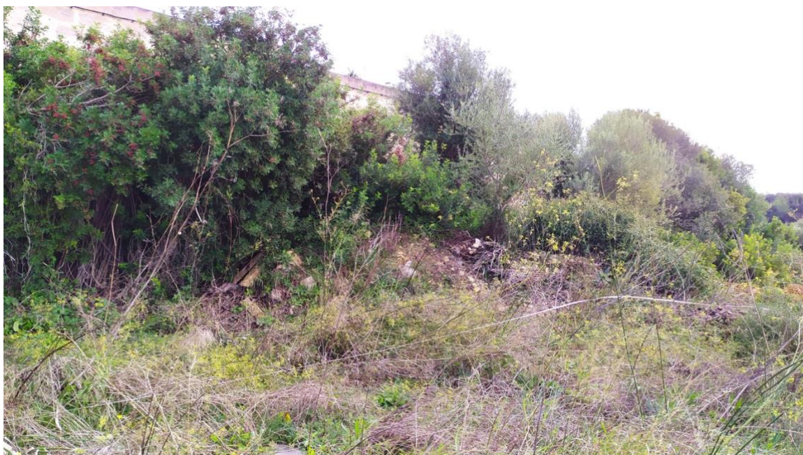
Foto 10. Escombros y material a retirar sobre el muro en seco.
