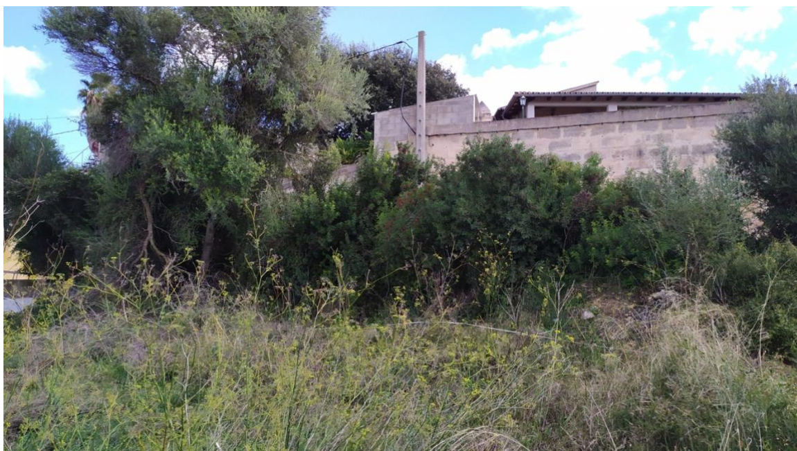
Foto 4. Situación general, vista inferior.
