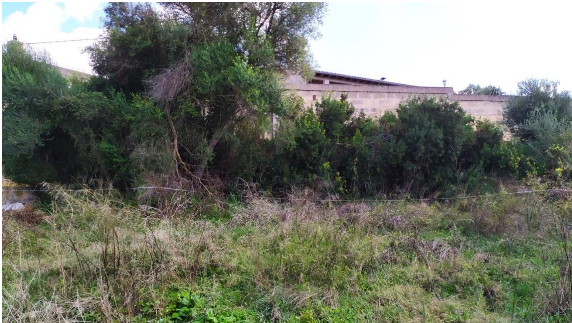
Foto 3. Situación general, vista inferior.
