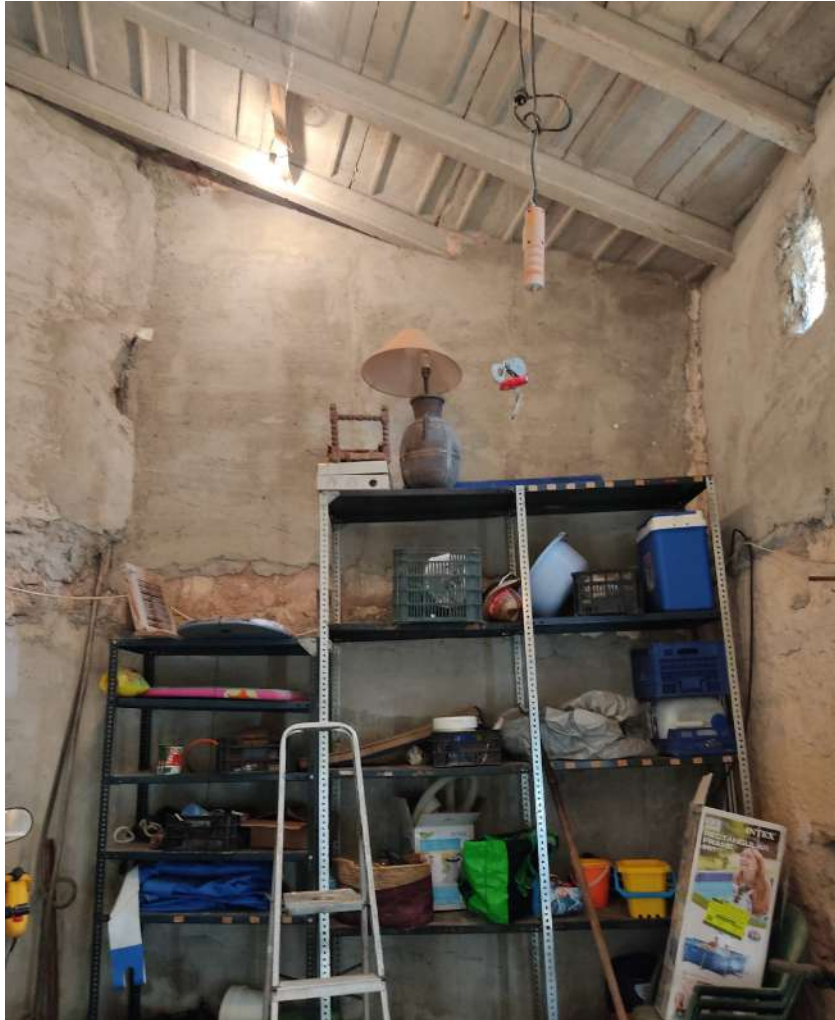
Figura 3.6. Detall de l'estat actual de l'interior
