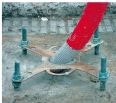
Detalle de realización de cimentación con pernos sueltos y plantilla.
