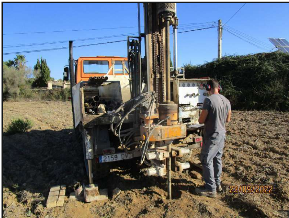
Foto 2: Detalle de la realización del sondeo S-1
