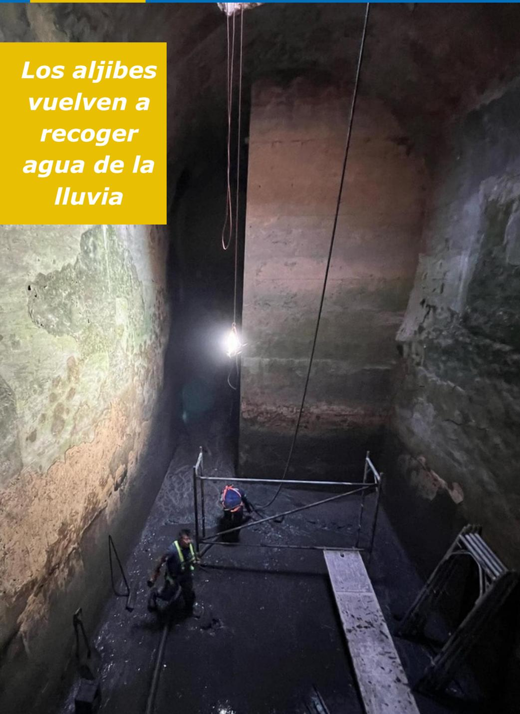
Los históricos **Aljibes de Costitx**, una construcción de 1886 y que fue creada por los Hermanos de la Caridad, ya se vuelven a utilizar. Después de los trabajos de limpieza, rehabilitación e impermeabilización ya recogen agua.
