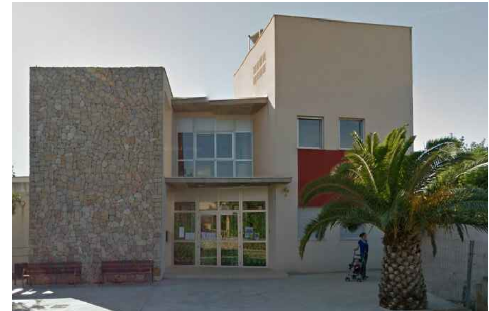
D2 Detalle Fotografia del Centro Educativo CEIP NADAL CAMPANER - COSTITX
